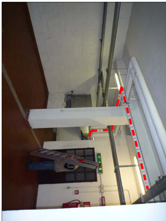
F01 – Piano Seminterrato – Tubazione coibentata con amianto
