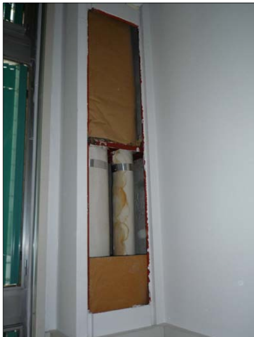
F05 – Piano Terzo e Primo – Cassonetto in ferro
