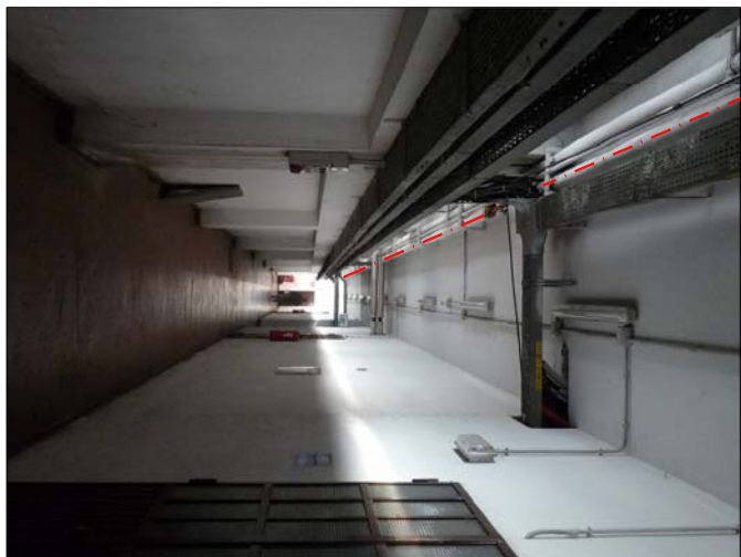
F03 – Piano Semi. – Tubazione coibentata con amianto
