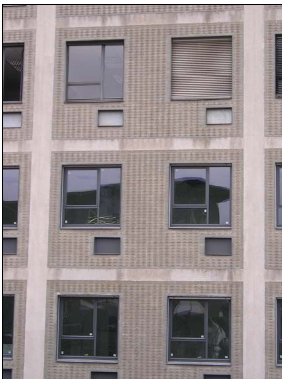
Foto 2 - Confronto tra infissi esistenti e sostituiti ai piani terra e primo
