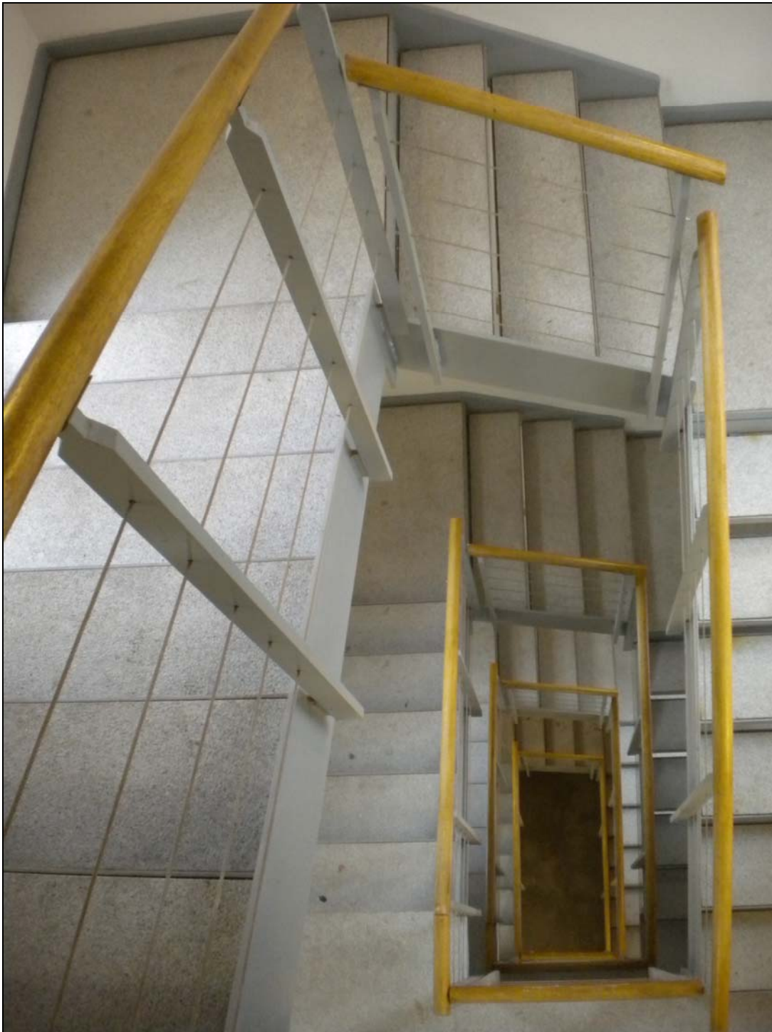
Foto nuova scala interna con pedate e pianerottoli in granito bianco di montorfano.
