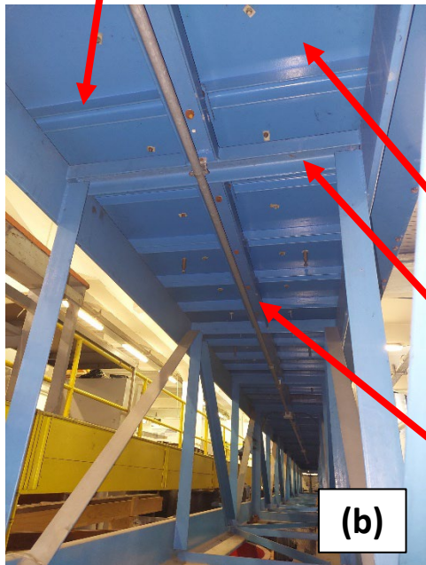
Figura 8.1: (a) struttura portante che sostiene il canale; (b) vista dal basso della struttura portante; (c) vista di insieme
