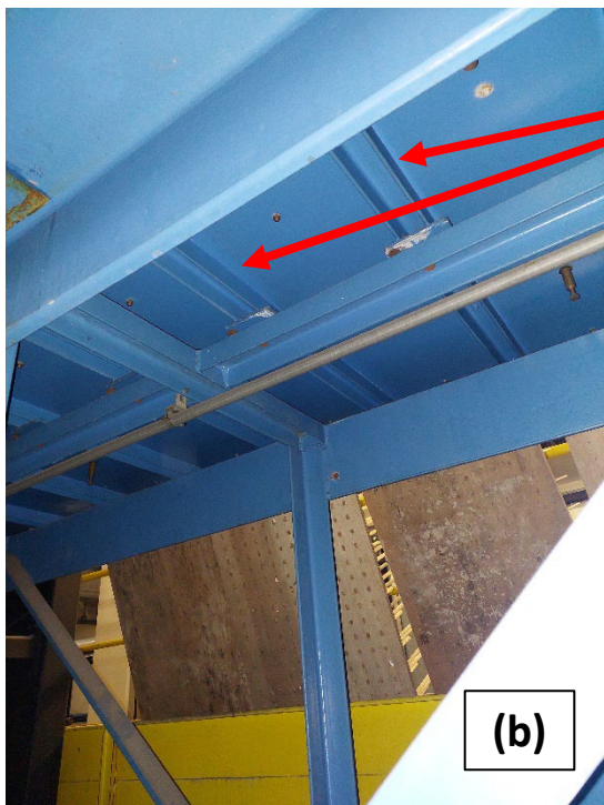
Figura 6.1: (b) traverso appartenente al concio del canale.
