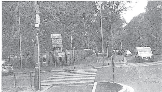
Marciapiede alberato lungo via Ponzio (lato est)
