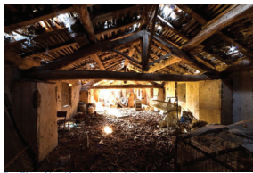
Figura 23: Interno del fabbricato con legno
