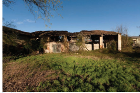
Figura 24: Esterno del fabbricato con erba
