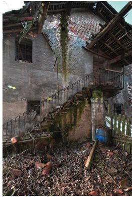
Figura 20: Staircase in metallo e legno
